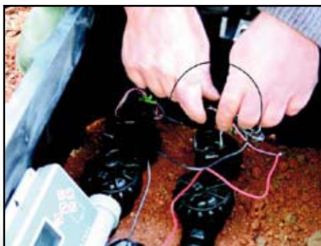
7. Ligue as electroválvulas ao cabo eléctrico através dos conectores estanques.
