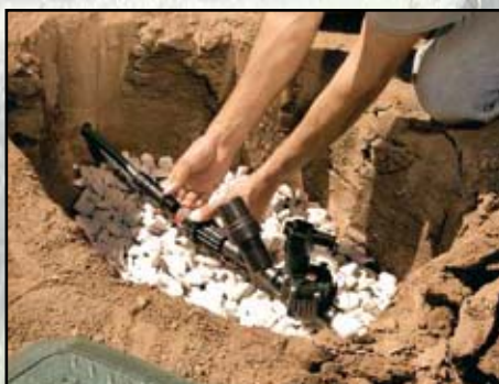
9. Instale o seu Kit inicial para zona de controlo de micro-rega.
